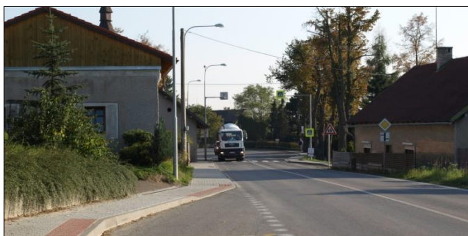
OBR.: dokončený přechod pro chodce v Bílém Újezdě
