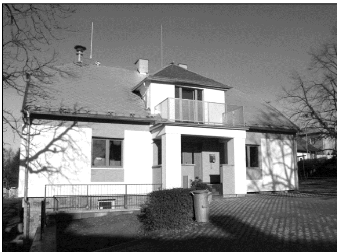
Budova obecního úřadu po rekonstrukci v roce 2014
