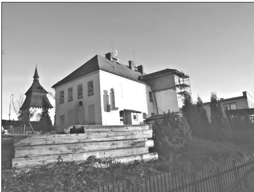
Zateplení ZŠ a MŠ Bílý Újezd
